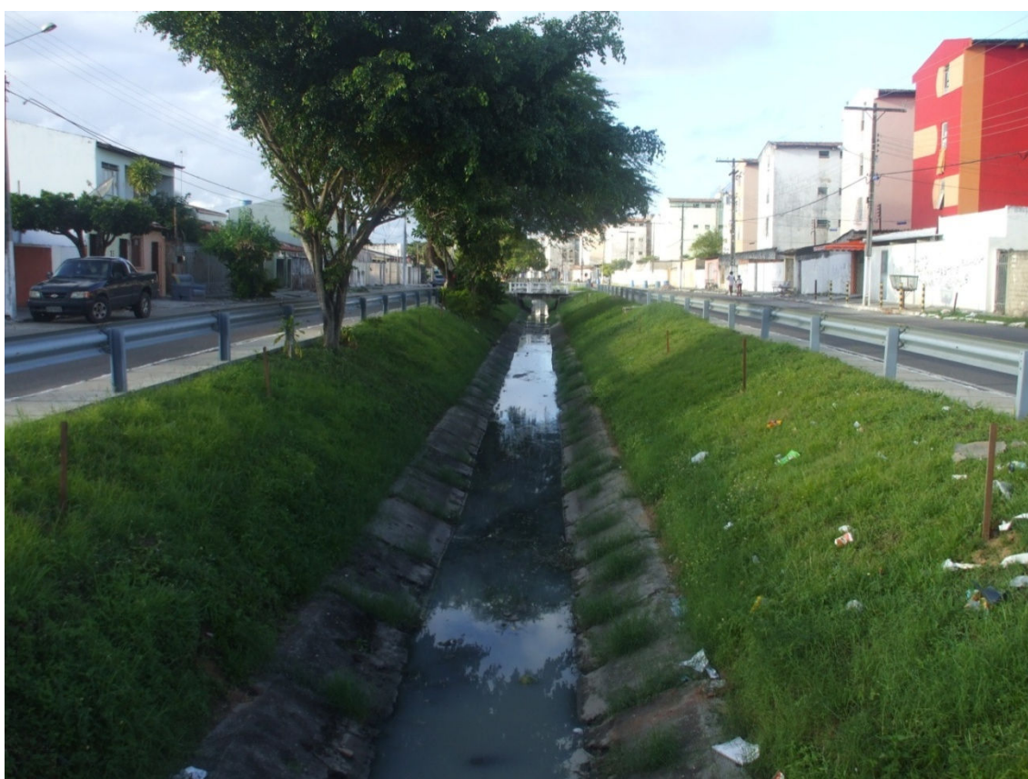
Figura 2 – Canais de esgoto à céu aberto, próximo à escola. Fonte: Arquivo Pessoal. Foto tirada dia 19 de julho de 2009.
