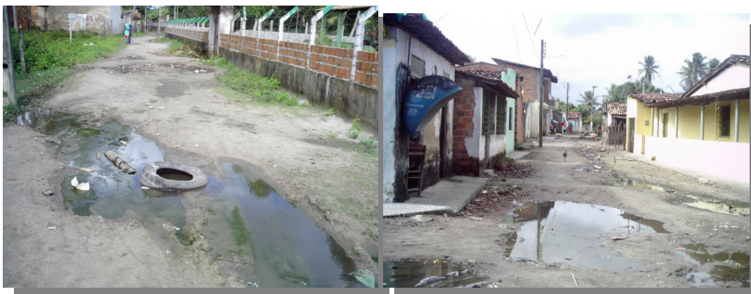
Fotos 19 e 20- Ausência de saneamento básico no povoado Taiçoca de Fora Fonte: Trabalho de campo, julho de 2009.
