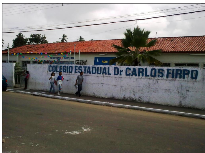
Figura 2 - Vista da fachada do Colégio Estadual Dr.Carlos Firpo, Barra dos Coqueiros-SE. (Foto: Aldeci dos Santos)
