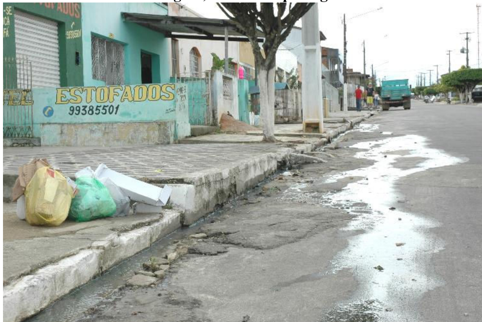
FOTO 03: Vista do esgoto, com destaque algumas bolsas de lixo.
