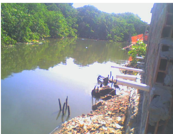
Fig. 3 Esgotos lançados das casas diretamente no manguezal.
