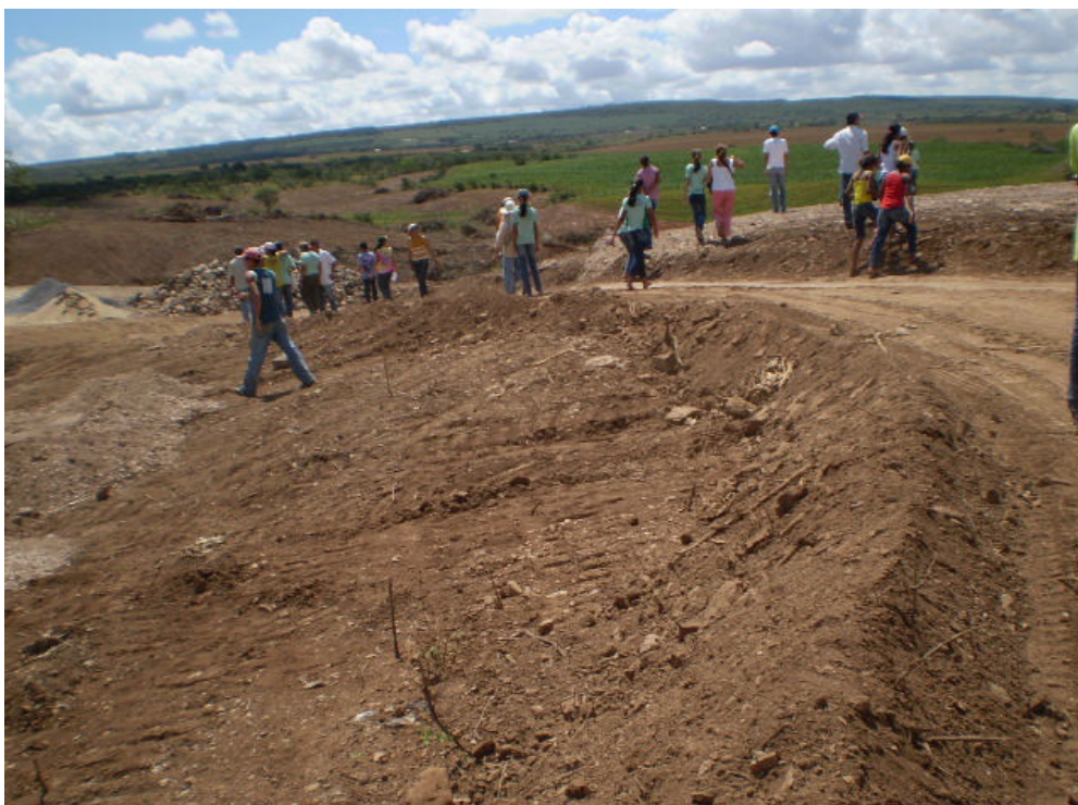
Figura 02. Área desmatada para construção da Barragem São José – Poço Verde/SE
